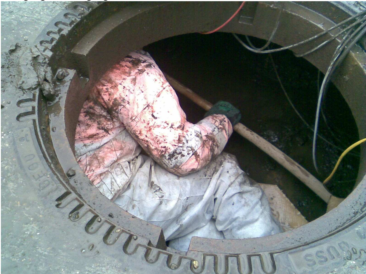
Reinigung der Waagengrube
