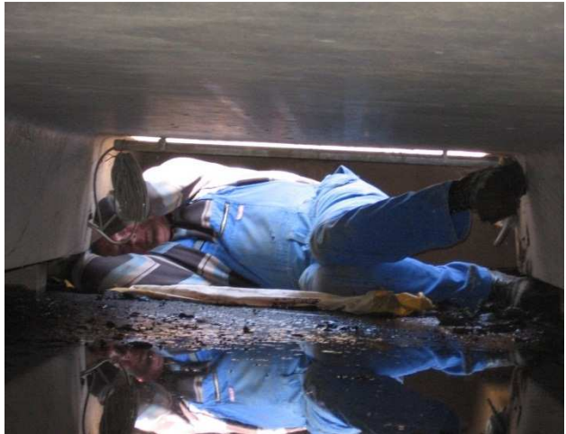
Wartungsarbeiten an einer Wägezelle
